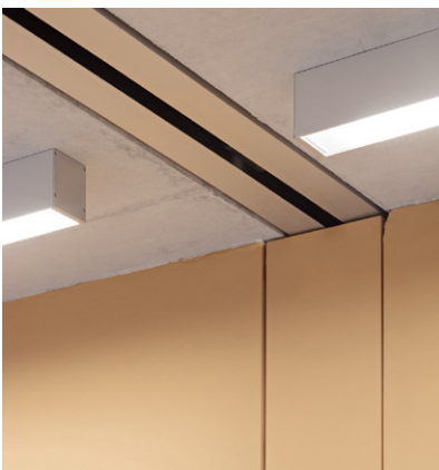
Deckenschiene bündig eingelassen. Farbliche Abstimmung möglich.
